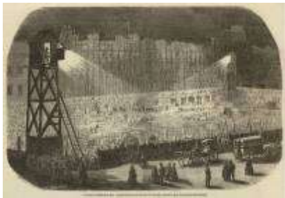
Travaux nocturnes des constructions de la rue de Rivoli, éclairés par la lumière électrique, L'illustration 1854• Crédits : Jules Galdran / Wikipédia
